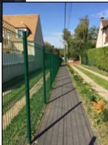
Elargissement du Chemin des Lavandières
