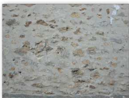
Enduit à pierre-vue par beurrage à l'enduit chaulé Faible couverture de la pierre
