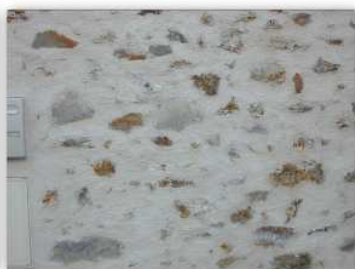
Enduit à pierre-vue par beurrage à l'enduit chaulé Couverture importante de la pierre
