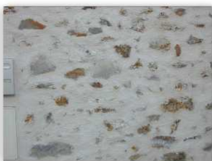
Enduit à pierre-vue par beurrage à l'enduit chaulé Couverture importante de la pierre
