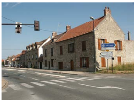
Accès depuis le centre bourg, vue vers le sud-est
