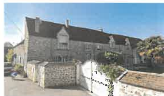
Lucarnes, situées sur la corniche du bâti Fortes pentes de toit - Arpenty
