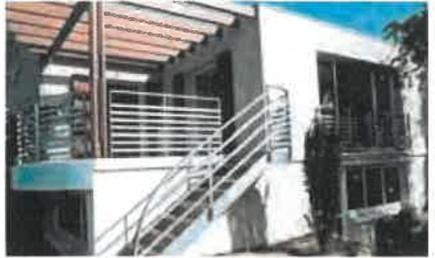
▲ À l'origine, un petit pavillon sans grande qualité architecturale et sans relation avec le terrain. L'extension, grâce à de grandes baies vitrées et un espace terrasse-pergola qui prolonge le séjour, ouvre largement la maison sur le jardin et au-delà.
