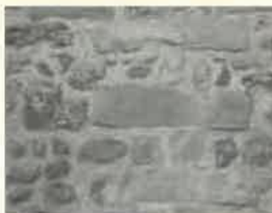
L'enduit affleure entre moellons de meulière et les pierres taillées de grès. ▼
