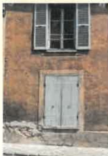
Les enduits de couleur ocre soutenue étaient fréquents sur les façades des maisons anciennes. ▼
