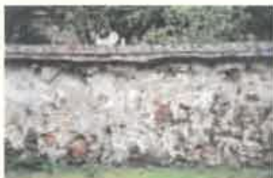
▲ Mur plein en maçonnerie de meulière.
