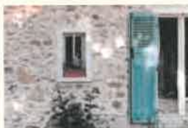
Enduit à pierre vue. ▲
