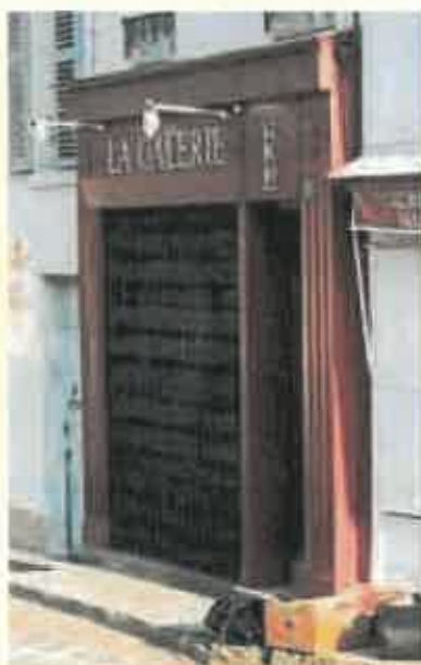
Dispositif fréquent d'éclairage d'une enseigne. ▼
