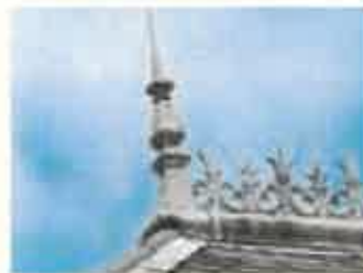
◀ Epi de faitage et crête en zinc.
