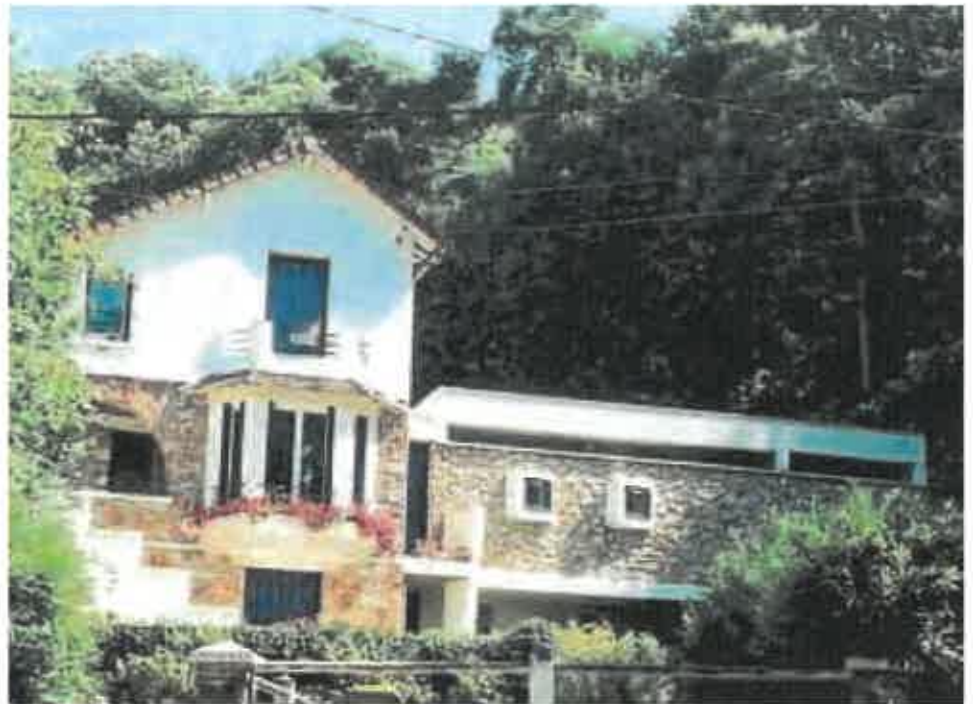
▲ Le volume de l'extension, simple, linéaire et bas, ne concurrence pas le volume ancien qu'il prolonge. La pierre de façade et la couleur de l'enduit contribuent à l'unité d'ensemble.
