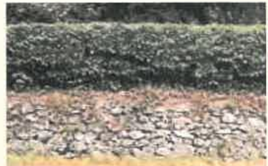
▲ Ce mur de soutènement est complété par une haie taillée dense.
