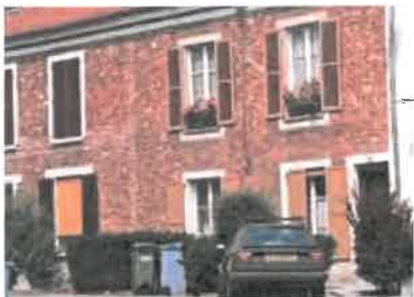
▲ Le rocaillage* est souvent réalisé avec un enduit à base de brique pilée qui donne cette teinte rosée.
