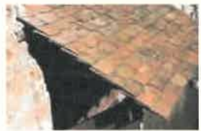
▲ Auvent d'un lavoir privé. Le recouvrement des tuiles est seulement de moitié.
