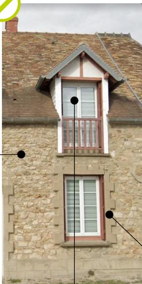
Les fenêtres doivent, sur les constructions anciennes, être verticales et de forme allongée
