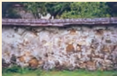
▲ Mur plein en maçonnerie de meulière.
