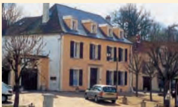
L'ardoise est adaptée aux fortes pentes. ▼
