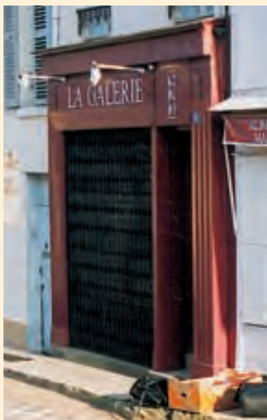
Dispositif fréquent d'éclairage d'une enseigne. ▼
