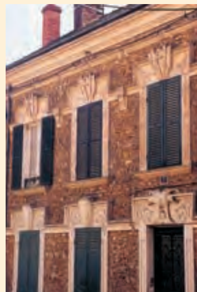
Exemple atypique d'ornementation des linteaux.
