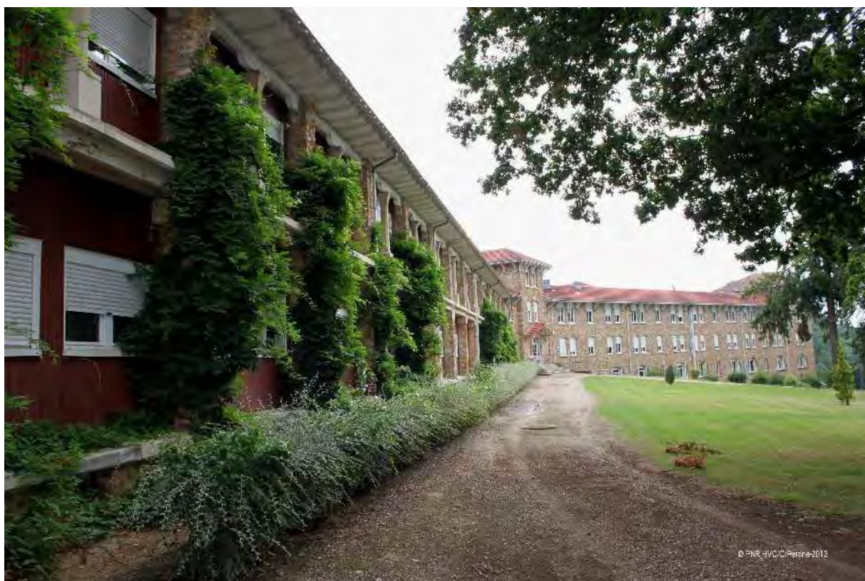
Façade sud du pavillon Despeaux, 2013
