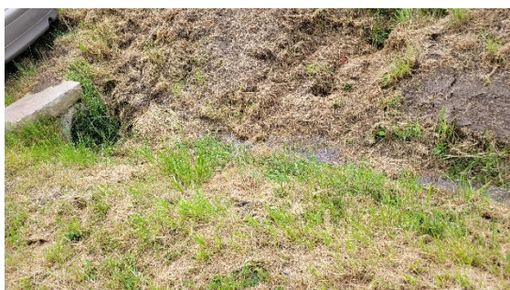
Arrivée du fossé le long de la voirie vers le réseau pluvial d'Arpenty (zone de débordement)
